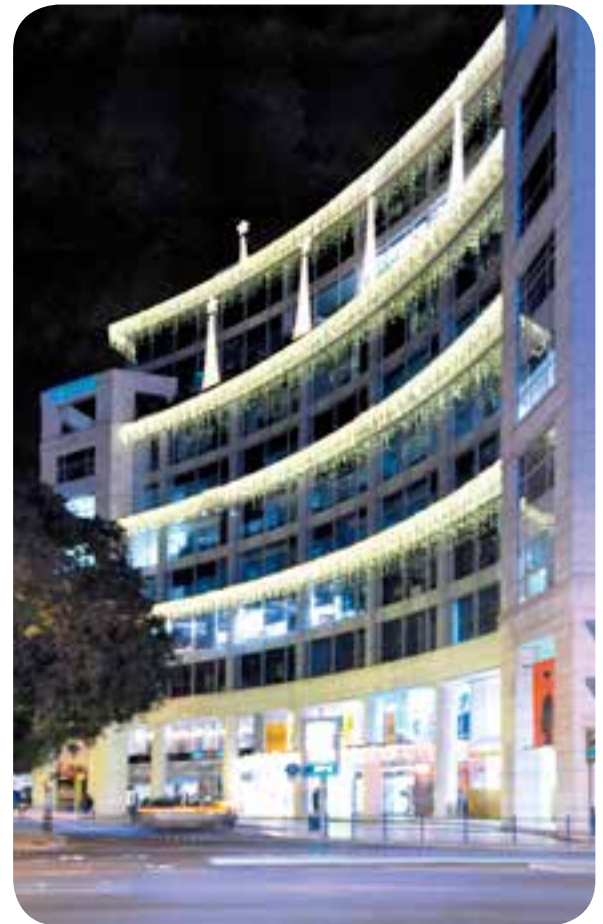
Icicles LED montados en balcones de un edificio (IBI04GWL)
