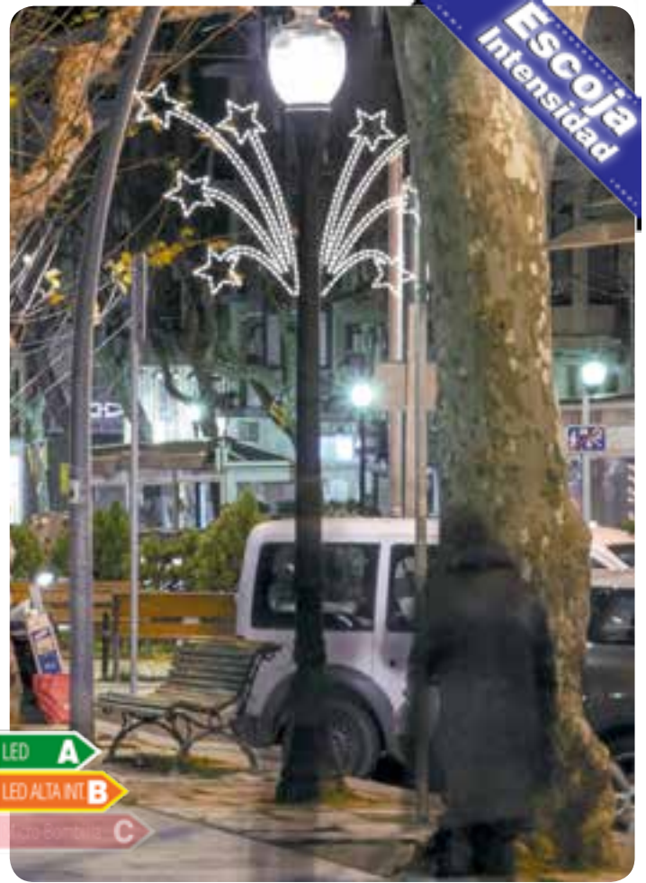
Montaje en farola de 2 unidades de la figura "Fuente de Estrellas".
