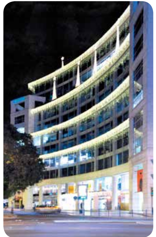
Icicles LED montados en balcones de un edificio (IBI04GWL)
