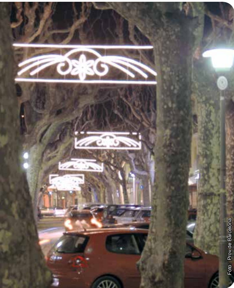
Montaje realizado con atirantado en el centro de una rambla Muntatge realitzat amb atirantat en el centre d'una rambla
